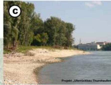
C Uferrückbau Abtrag der Steinverbauung
