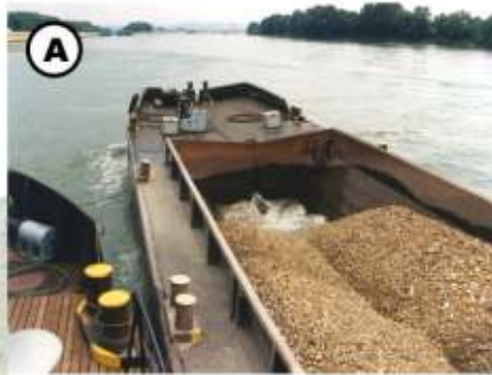
A Sohlanpassung und Granulometrische Sohverbesserung – Erprobung der Einbaumethode
