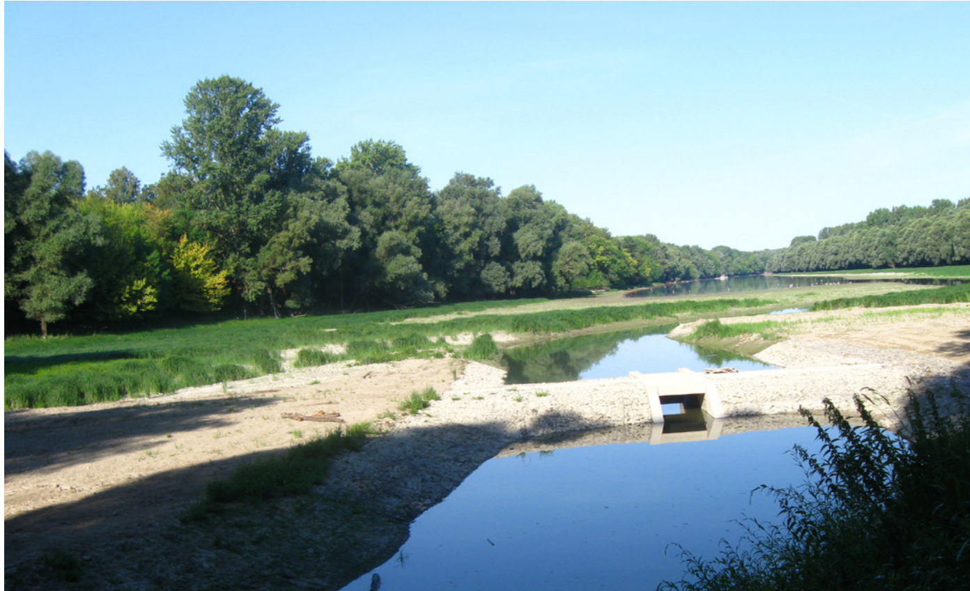
Fenekküszöb áteresszel a leürülés megakadályozására a Grébec-Dunán
